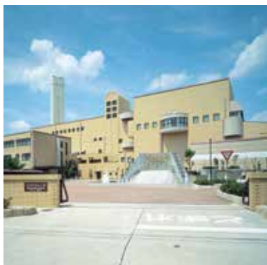
名古屋市環境事業局富田工場 S-1-3仕様 5,777㎡ 設計 (株)大建設 元請 熊谷・戸田・浅沼・東急・伊藤共同企業体
