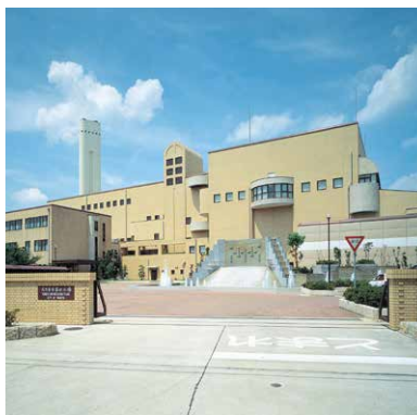
名古屋市環境事業局富田工場 S-1-3仕様 5,777㎡ 設計 (株)大建設計 元請 熊谷・戸田・浅沼・東急・伊藤共同企業体
