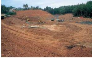
堤頂部及び底面を十分に転圧し平滑に均し、法面部には土羽打ちを完全に行います。
