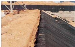
コンクリート部に於けるシートの張仕舞部処理は、ラップ又は押え金具で処理。土壌面でのシートの張仕舞はシートの端末を埋込溝に敷き込み、土砂・コンクリート等を投入し完全に固定します。
