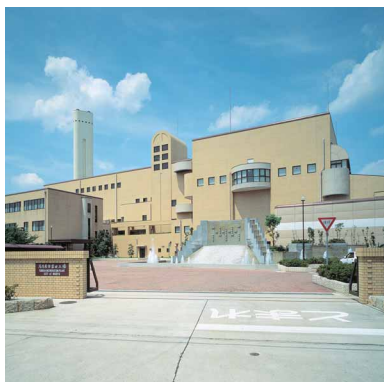
名古屋市環境事業局富田工場 S-1-3仕様 5,777㎡ 設計 (株)大建設 元請 熊谷・戸田・浅沼・東急・伊藤共同企業体
